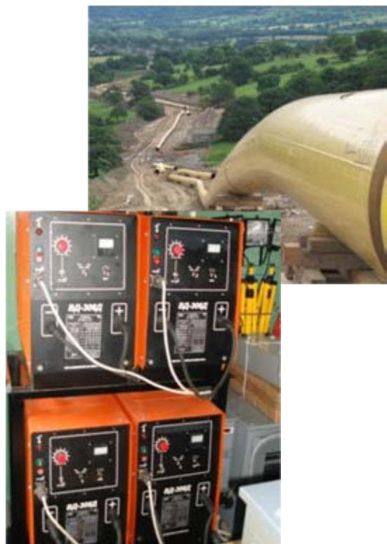
Фото внутри оборудованного передвижного комплекса сварочных работ (ПКСР)
