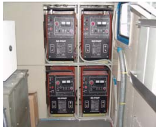
Оборудованный подвижной комплекс сварочных работ
